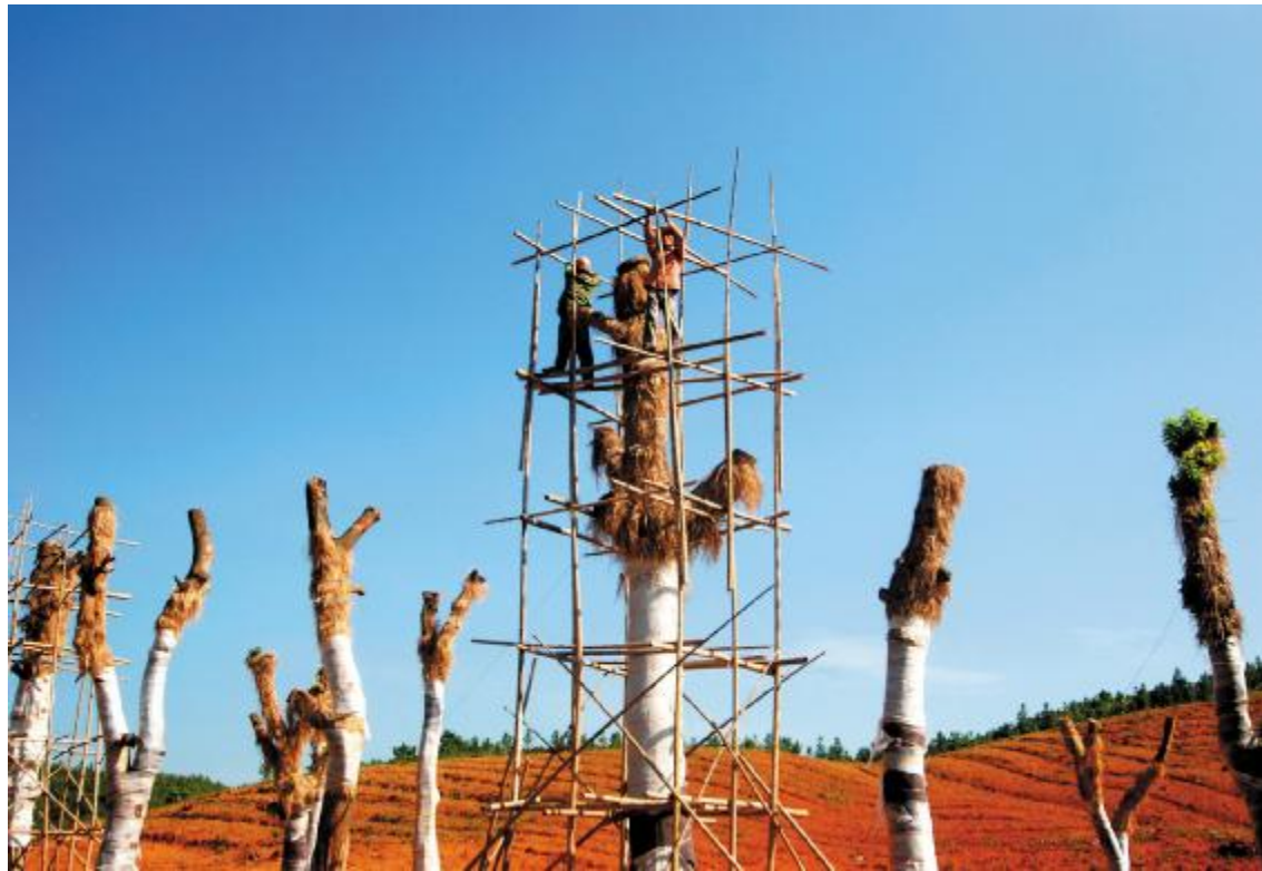
6 月 18 日,在江西省吉安市峡江县城郊森林公园,工人们为峡江水利枢纽工程水淹区移植过来的名木古树搭建遮荫棚。目前,峡江水利枢纽工程水淹区的名木古树抢救性迁移工作已基本完成,共转移樟树、枫树、栎木、石楠、槐树、罗汉松等 3000 余棵。陈福平摄(新华社供图)
